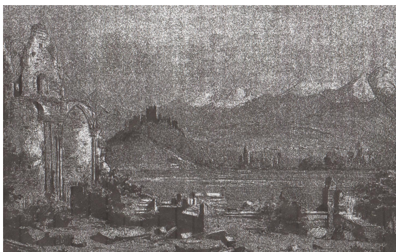
Ruines du château de La Chambre en Maurienne
