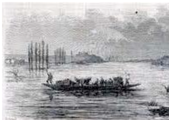
Figure 33 - Bac chargé traversant le fleuve
