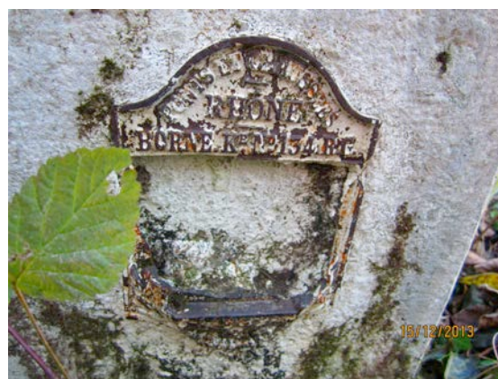
Figure 64 - Ancienne borne kilométrique du Rhône près de Chanaz. Ces bornes des Ponts et Chaussées, installées au milieu du XIX e jalonnent le Haut Rhône de Seyssel à Lyon (Clichés de l'auteur)
