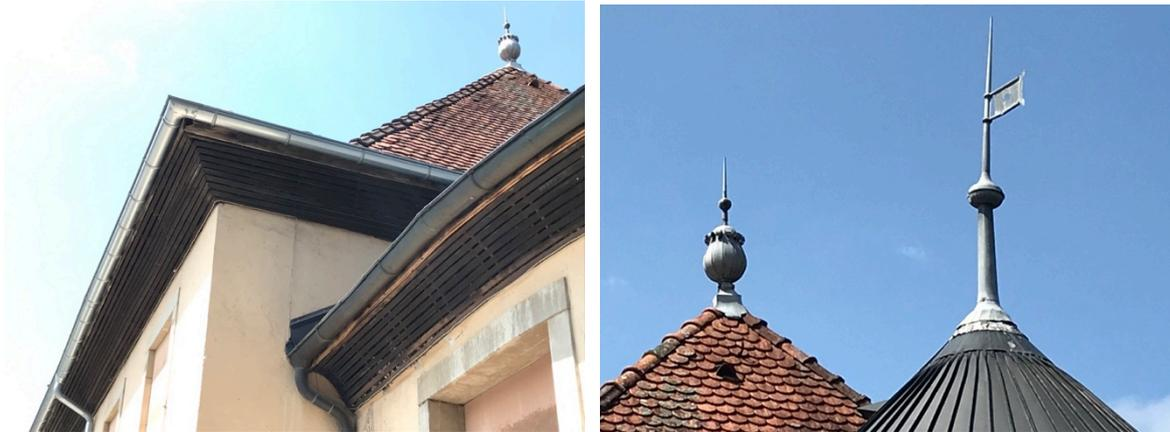
Sur tout le pourtour du bâtiment, le toit déborde d'un peu moins d'un mètre avec un encorbellement fermé par une douzaine de fines lattes en bois horizontales. La haute toiture en tuile est couronnée à chacune de ses deux extrémités par un vase acrotère, tandis que la toiture du chevet est surmontée d'une pointe avec un petit étendard en métal, épis de faîtage (on retrouve ce même étendard sur la toiture de la Villa Gorge édifée par Maurice Brailard à l'entrée de Samoëns).
